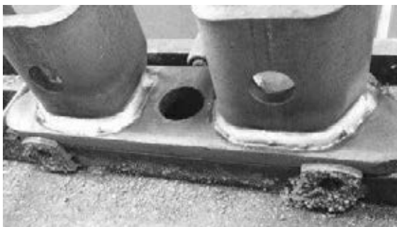
Slika 4: Varjenje z novo mešanico (levo) in Ar + 5%CO 2 + 5%O 2 (desno)
